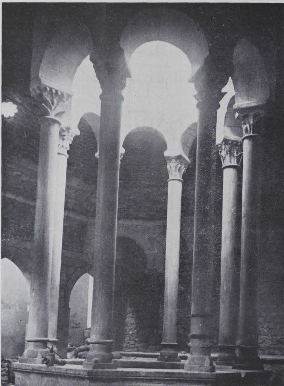
Fig. 321. — Frigidari dels banys de Girona després de la restauració
